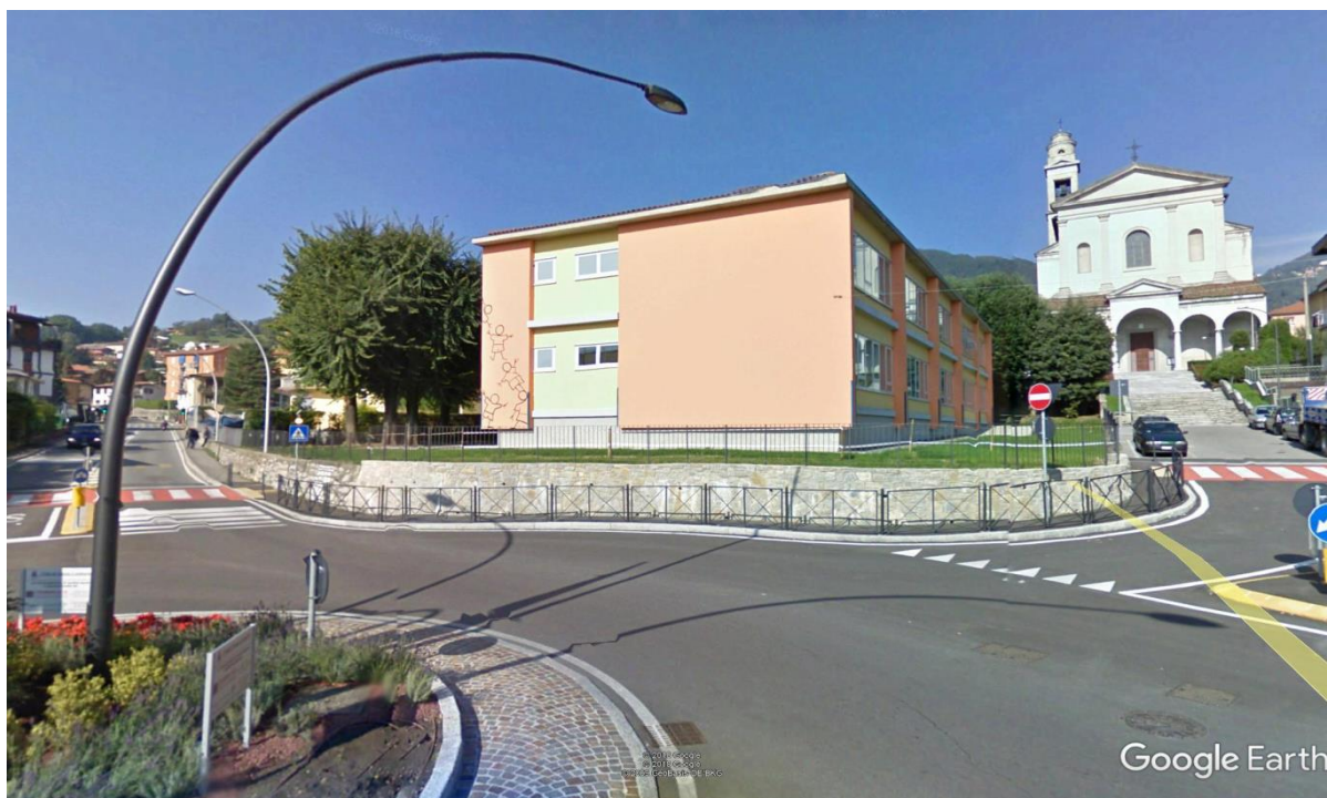
vista da via Provinciale
