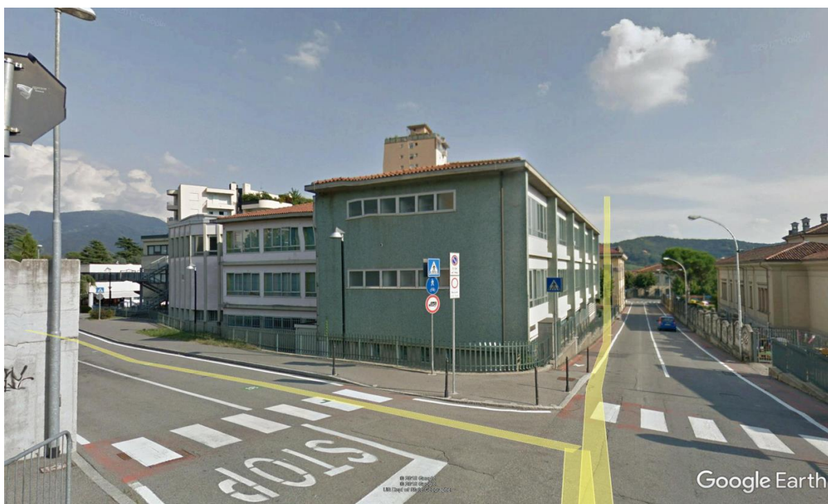
vista da via Valenti (nord)
