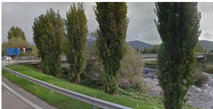
Figura 3 - Alzano Lombardo, ponte su SP 67 verso Villa di Serio e SP 35
