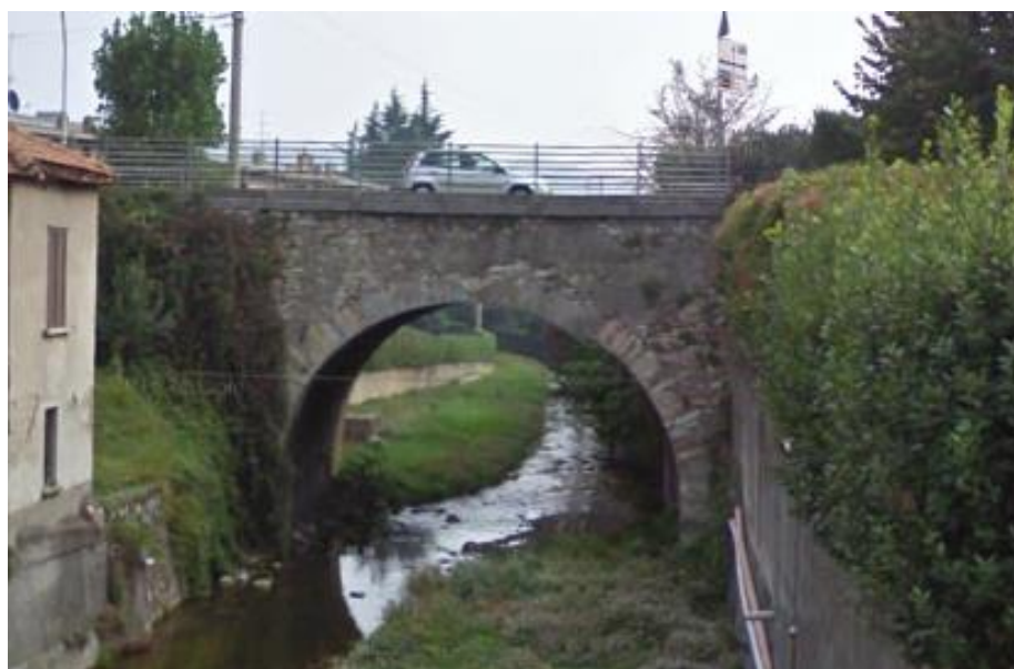
Figura 5 - Alzano Lombardo, ponte via Provinciale su Torrente Nesa
