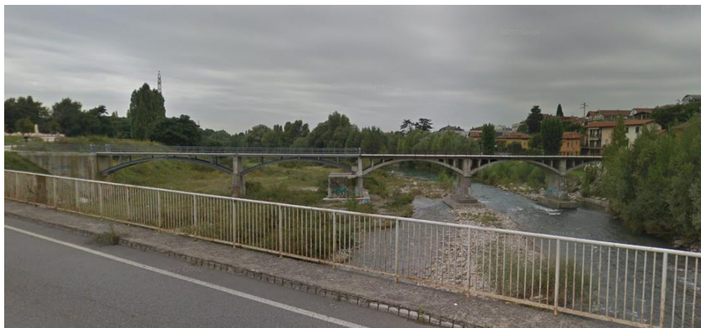
Figura 4 - Alzano Lombardo, ponte ciclopedonale visto da ponte su SP 67
