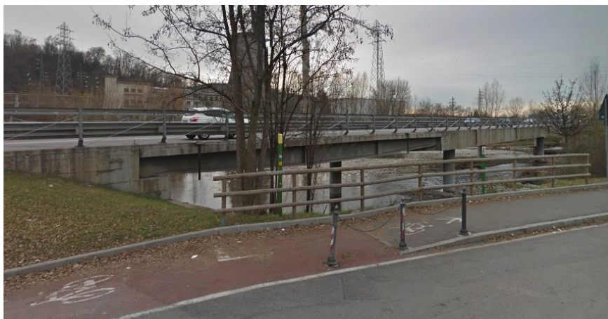
Figura 2 - Alzano Lombardo, ponte su SP35 in zona industriale al confine con Nembro
