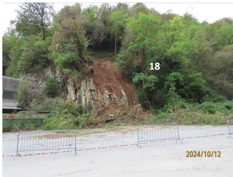
Foto 4.42 Frana n. 18 – frana attiva
