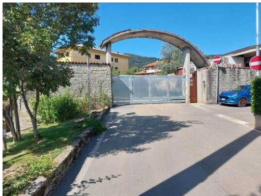
Foto 4.71 Vista di Via Licini dove si nota le tracce del fango lungo la strada
