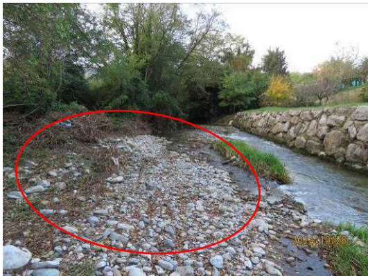
Foto 4.82 Area allagata in destra idrografica del Torrente Nesa
