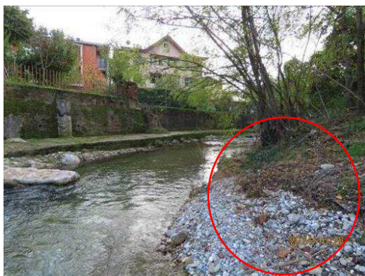
Foto 4.84 V Area allagata in destra idrografica del Torrente Nesa
