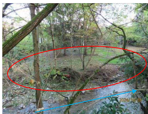
Foto 4.79 Area allagata in sinistra idrografica del Torrente Nesa (direzione della freccia azzurra)
