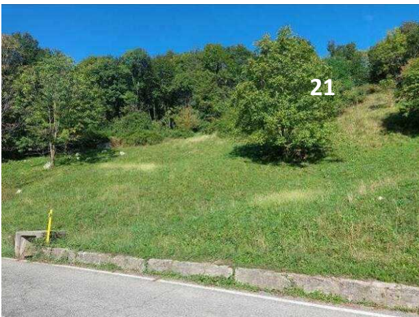
Foto 4.48 Frana n. 21 – frana quiescente
