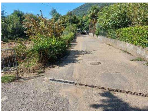
Foto 4.86 Ingresso di Via Busa
