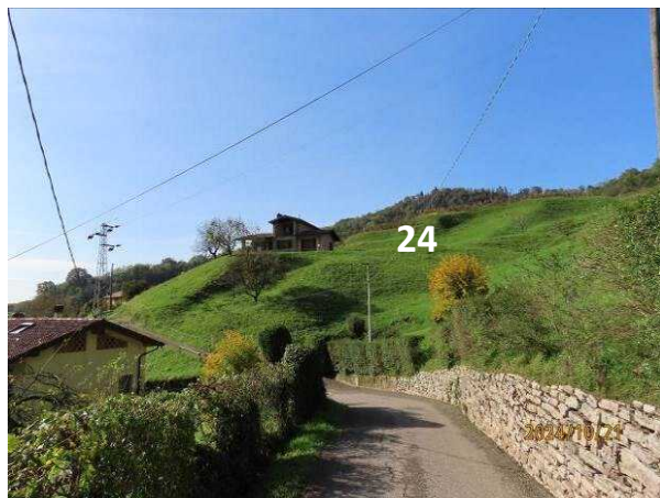
Foto 4.54 Frana n. 24 – frana quiescente
