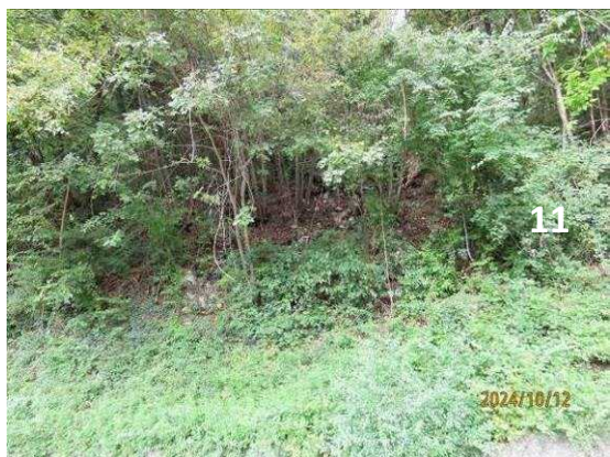
Foto 4.21 Frana n. 11 – frana attiva vista dalla strada
