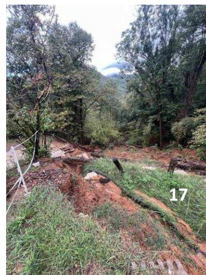
Foto 4.41 Frana n. 17 – frana attiva
