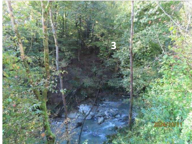
Foto 4.3 Frana n. 3 – frana attiva
