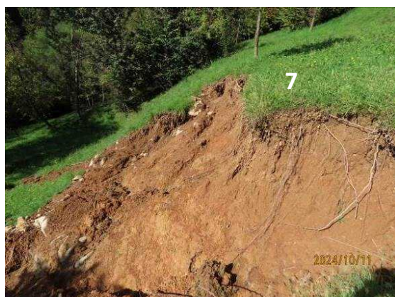
Foto 4.13 Frana n. 7 – frana attiva
