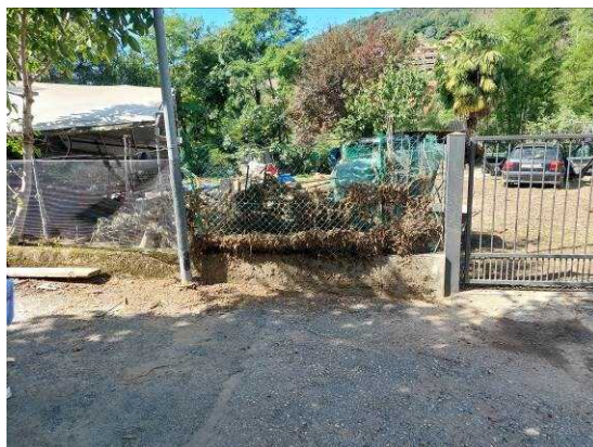
Foto 4.90 Vista di Via Busa dove si nota materiale grossolano e legname lasciato dal passaggio del Torrente Nesa in un giardino di proprietà privata
