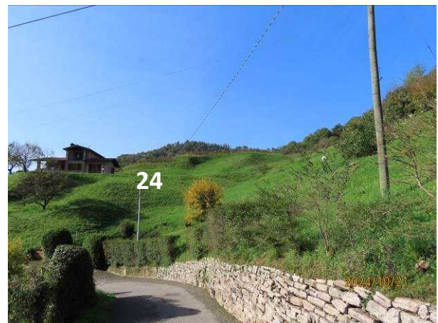
Foto 4.55 Frana n. 24 – frana quiescente
