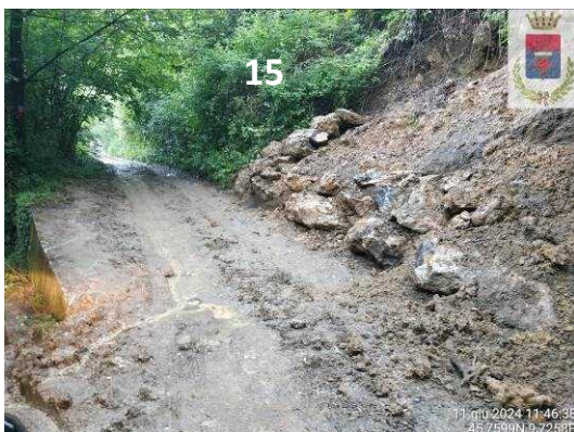
Foto 4.34 Frana n. 15 – frana attiva
