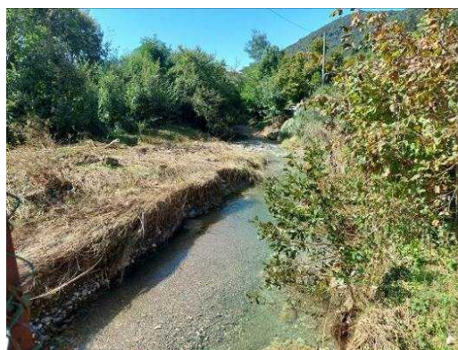
Foto 4.87 Vista della sponda idrografica destra del Torrente Nesa di fronte Via Busa dove si nota presenza di materiale e piante
