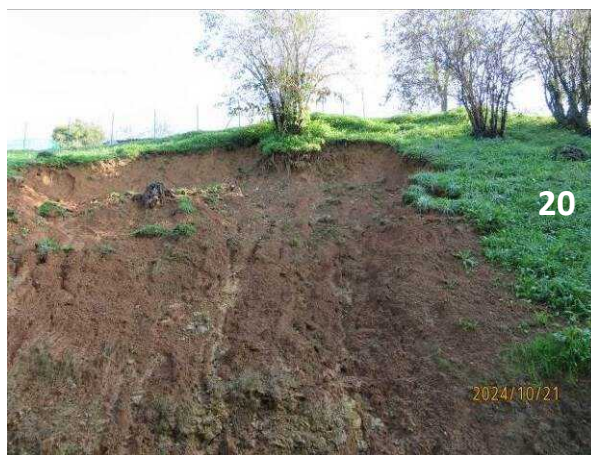
Foto 4.45 Frana n. 20 – frana attiva
