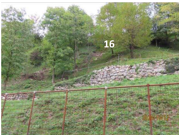
Foto 4.36 Frana n. 16 – frana attiva
