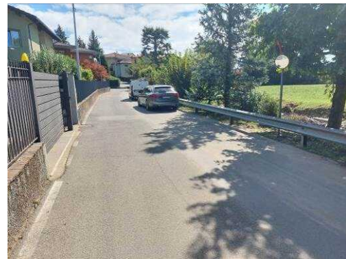
Foto 4.72 Vista di Via Licini dove si nota le tracce del fango lungo la strada
