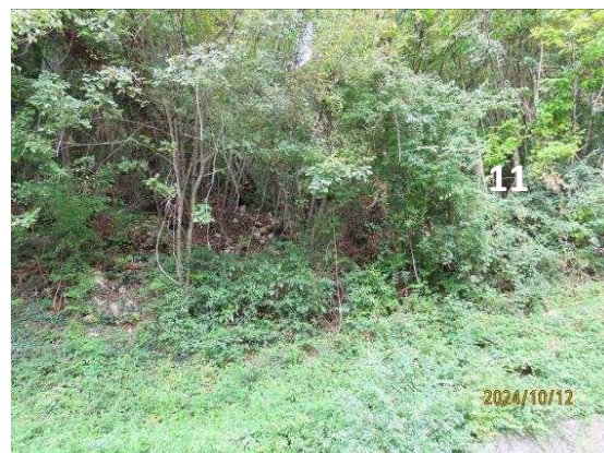
Foto 4.22 Frana n. 11 – frana attiva vista dalla strada
