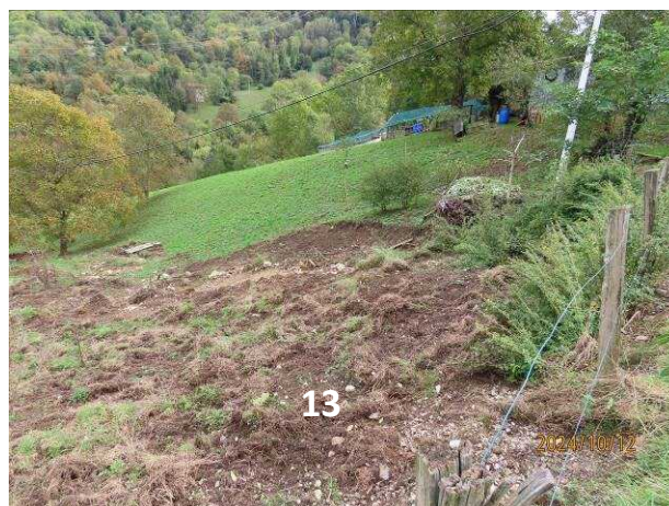
Foto 4.27 Frana n. 13 – frana attiva
