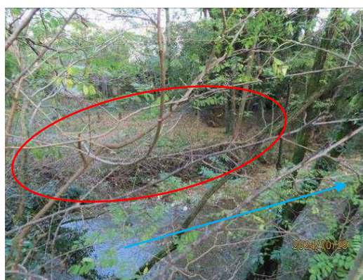
Foto 4.81 Area allagata in sinistra idrografica del Torrente Nesa (direzione della freccia azzurra)
