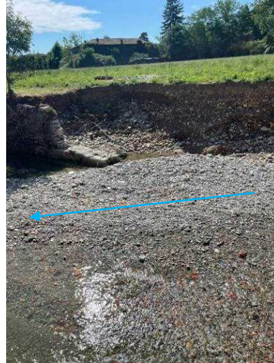
Foto 3.76 Argine del Torrente Nesa in destra idrografica del Torrente Nesa in corrispondenza di Via Licini
