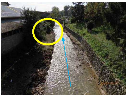
Foto 3.67 Rottura argine in sponda idrografica del Torrente Nesa (freccia azzurra)
