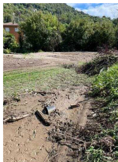
Foto 3.94 Vista della zona allagata G
