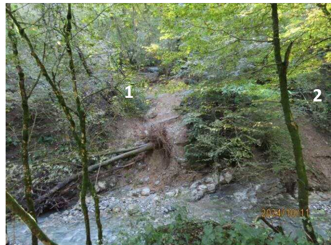
Foto 3.2 Frana n. 1 – frana attiva e n. 2 – frana attiva
