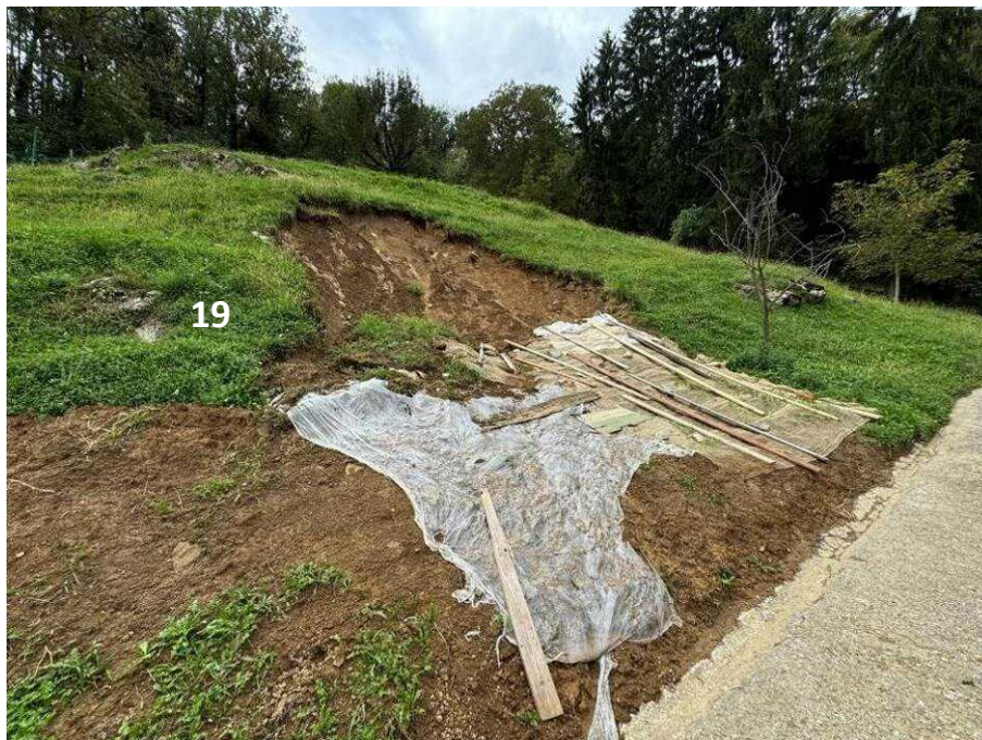
Foto 3.43 Frana n. 19 – frana attiva
