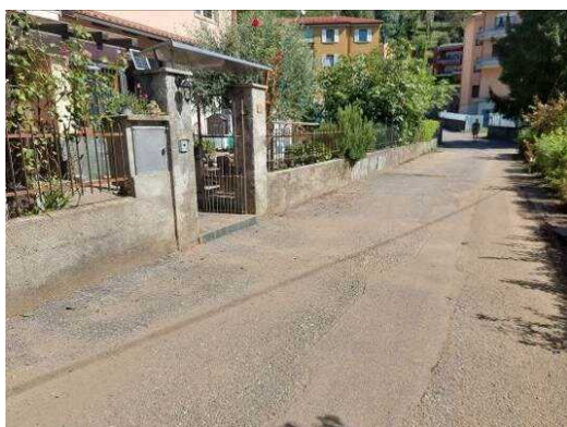
Foto 3.88 Via Busa dove si nota la presenza del fango lungo la strada
