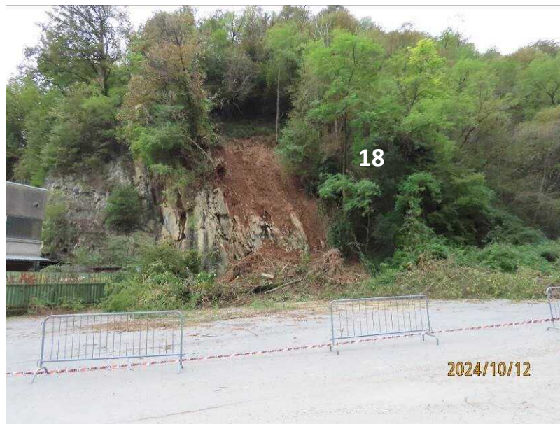
Foto 3.42 Frana n. 18 – frana attiva
