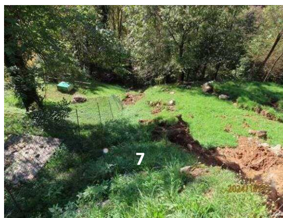
Foto 3.14 Frana n. 7 – frana attiva
