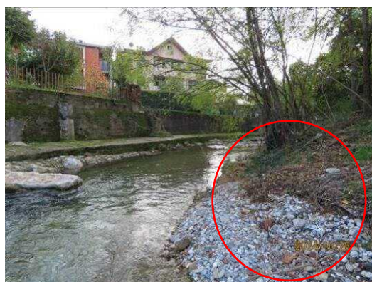
Foto 3.84 V Area allagata in destra idrografica del Torrente Nesa
