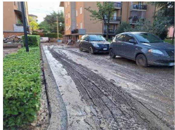
Foto 3.61 Esondazione presso le abitazioni di Via Nicoli
