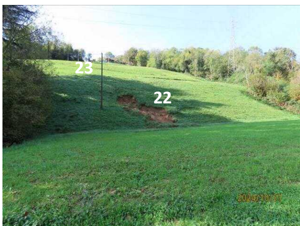
Foto 3.52 Frana n. 22 – frana attiva e frana n. 23 – frana quiescente
