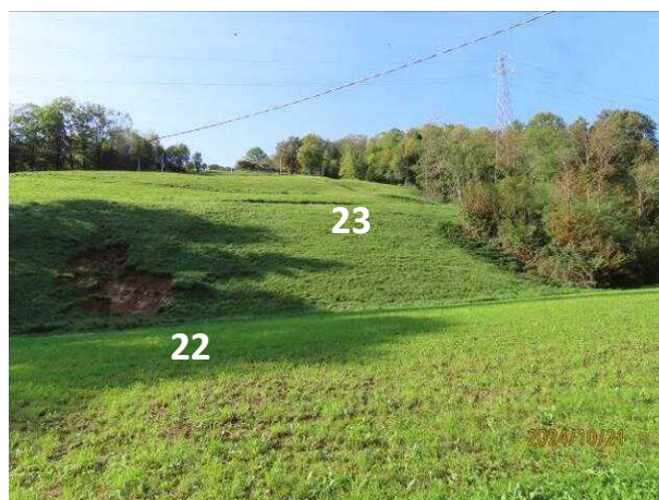
Foto 3.53 Frana n. 22 – frana attiva e frana n. 23 – frana quiescente
