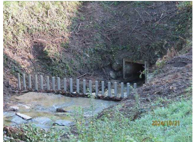
Foto 3.102 Vista dell'imbocco del tratto intubato sottodimensionato
