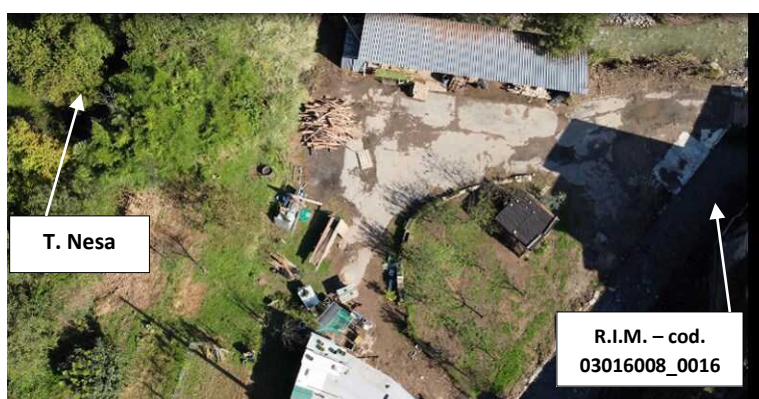
Foto 3.99 Vista della zona H da monte verso valle
