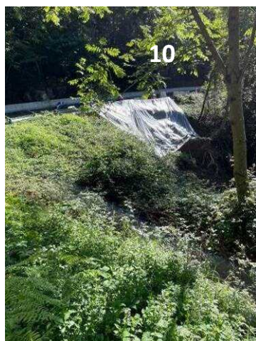
Foto 3.18 Frana n. 10 – frana attiva
