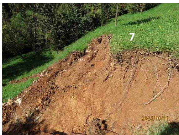
Foto 3.13 Frana n. 7 – frana attiva
