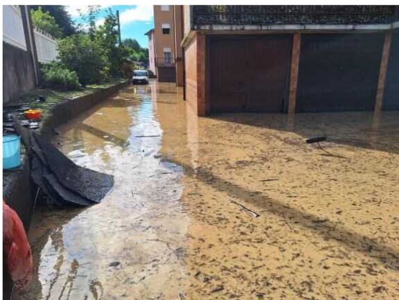
Foto 3.58 Esondazione presso le abitazioni di Via Nicoli
