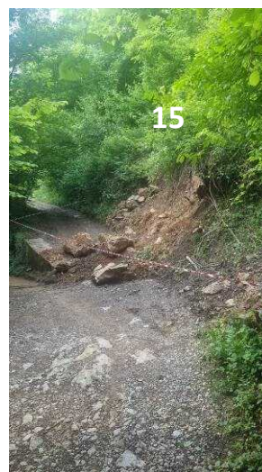
Foto 3.33 Frana n. 15 – frana attiva
