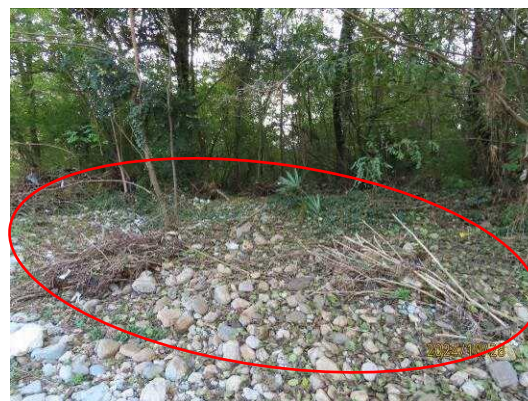
Foto 3.83 Area allagata in destra idrografica del Torrente Nesa
