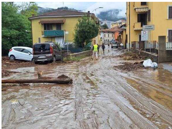
Foto 3.64 Vista di Via Nesa allagata dalla fuoriuscita del Torrente Nesa
