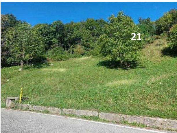
Foto 3.48 Frana n. 21 – frana quiescente
