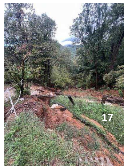
Foto 3.41 Frana n. 17 – frana attiva
