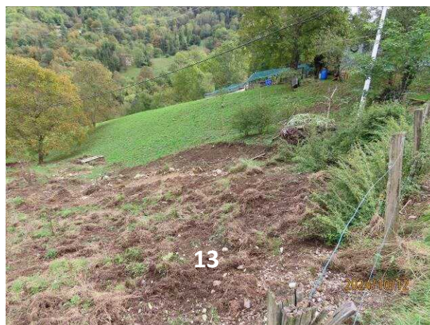
Foto 3.27 Frana n. 13 – frana attiva
