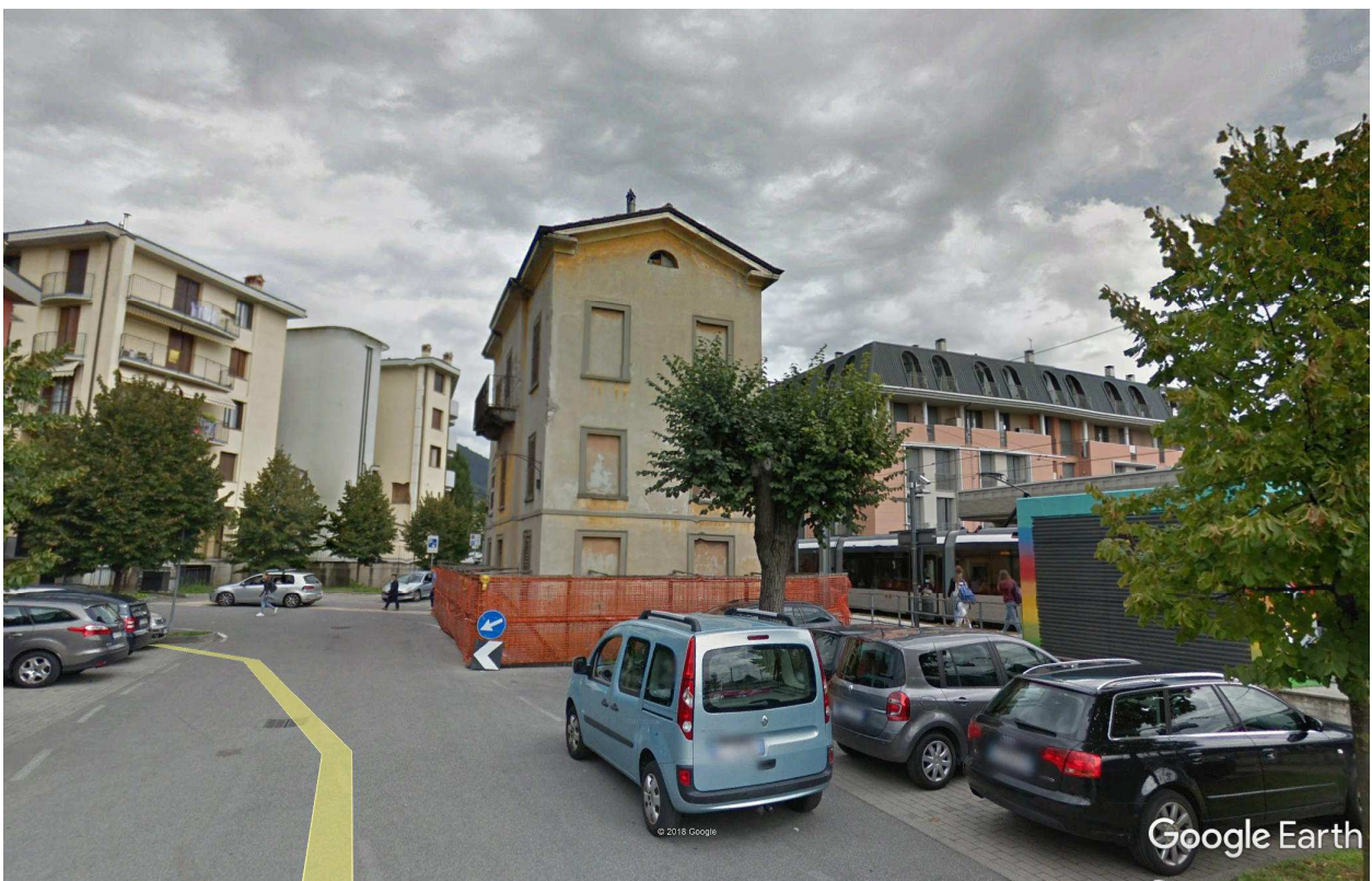
foto 2 – vista da Sud
